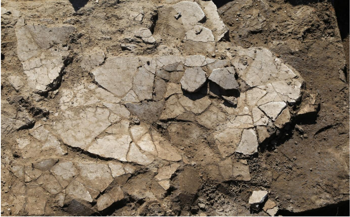
İnşaat Sıvası (Anıt Yapı)
